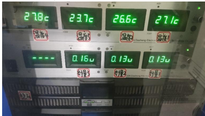
固定式辐射监测系统
